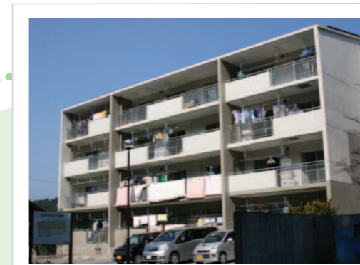
町営住宅(谷下団地)
